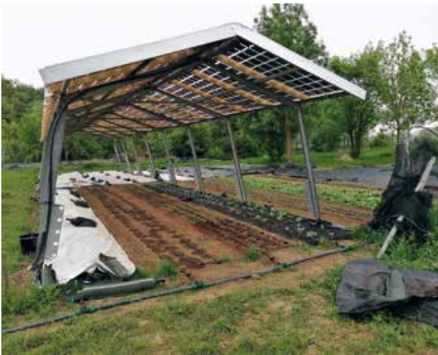
Abbildung 1. Beete unter der PV-Anlage und daneben zu Jahresbeginn 2024. (© Judt/FiBL)
